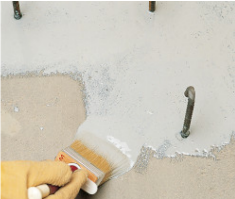
Eporip felhordása munkahézag kötőhídaként
