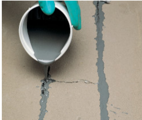
Cementkötésű esztrich repedésjavítása Eporip-pel
