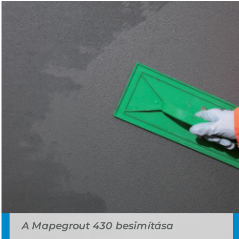
A Mapegrout 430 bedolgozása simítóval
