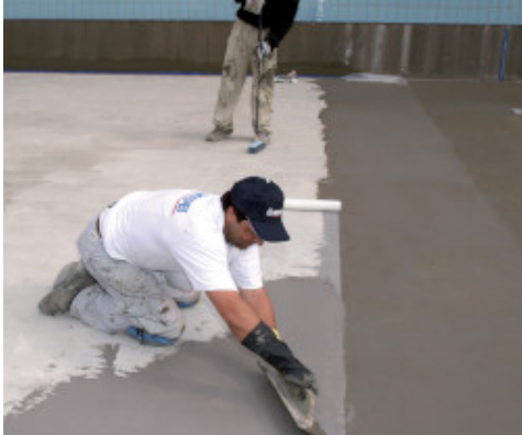
Úszómedence vízszigetelése Mapelastic-kal
