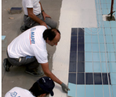
Kerámia burkolólapok fektetése Mapelastic-ra úszómedencében
