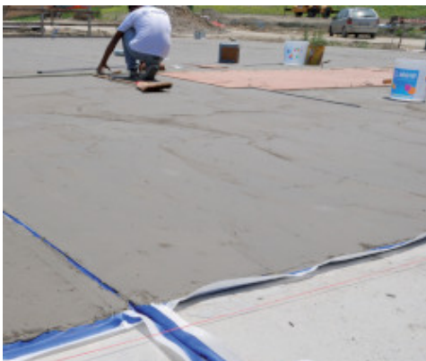
Esztrichek vízszigetelése Mapelastic -kal és Mapeband -dal
