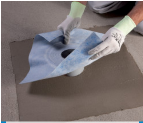
Drain Vertical beépítése Mapelastic-ra
