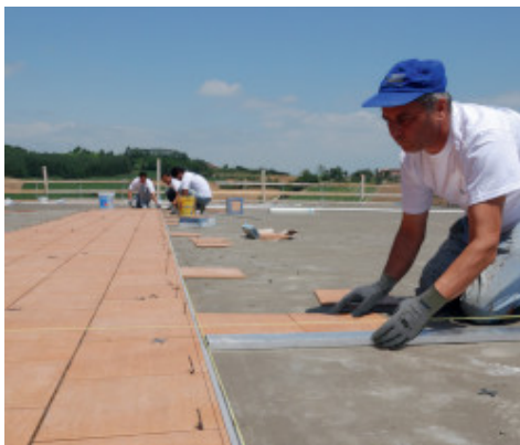
Kerámia burkolólapok fektetése Kerabond + Isolastic keverékkel
