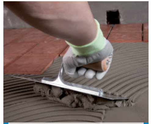
Granirapid felhordása Mapelastic-kal vízszigetelt teraszra
